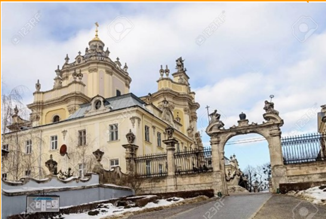
Immagine d'assieme del complesso della cattedrale di San Giorgio
